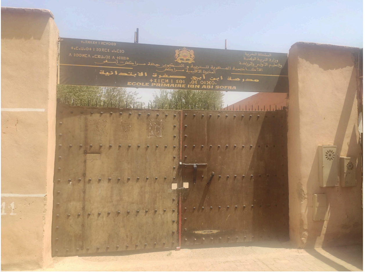
Fas'ta kapıları kilitli bakımsız bir ilkokul.
